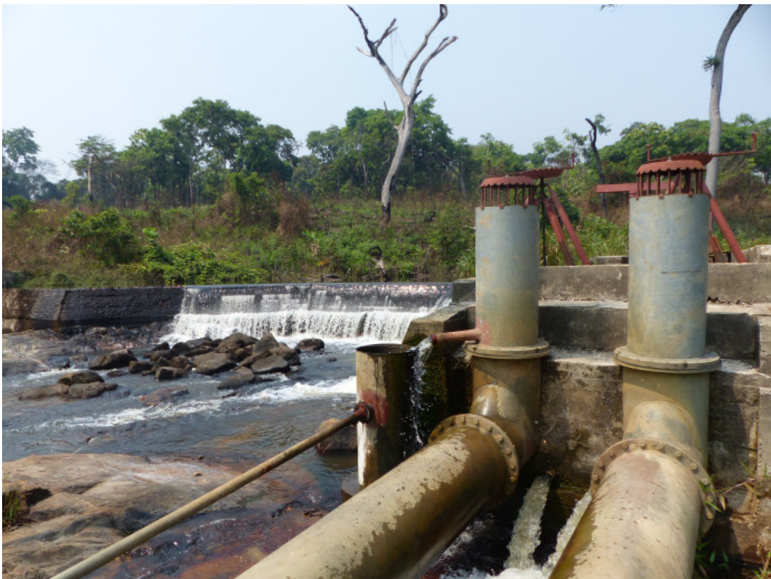
Der Damm, der für das ELKAP-Projekt gebaut wurde, an der Stelle, an der Druckrohrleitungen die Turbinenstation mit Wasser versorgen
